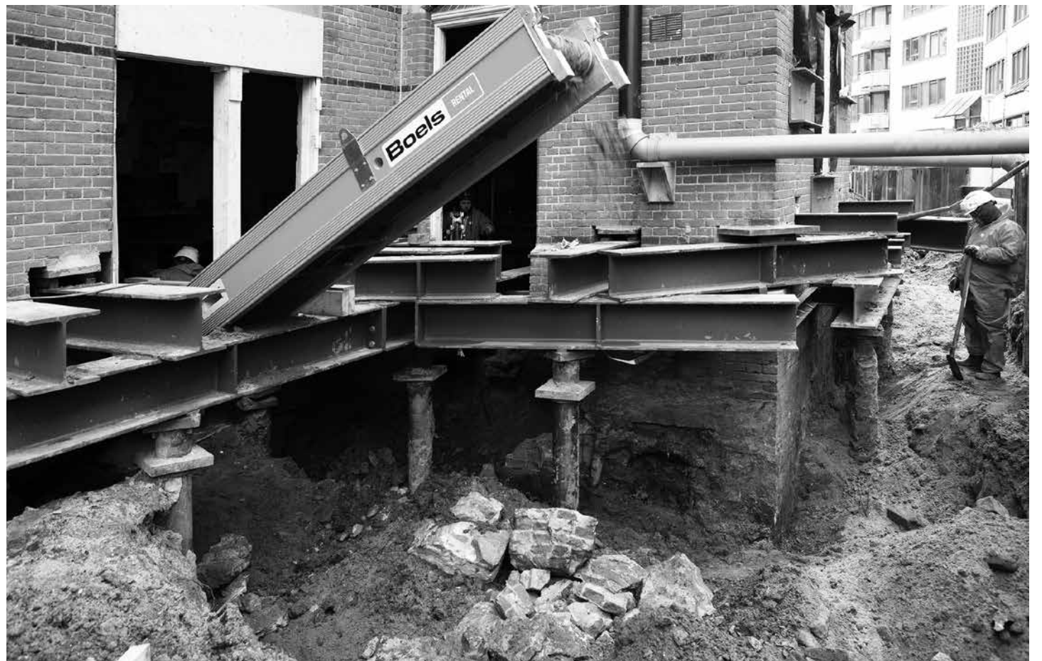
Op een aantal plaatsen kun je al onder het gebouw door kijken
