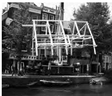
Montage en plaatsing van gloednieuwe kapconstructie...
