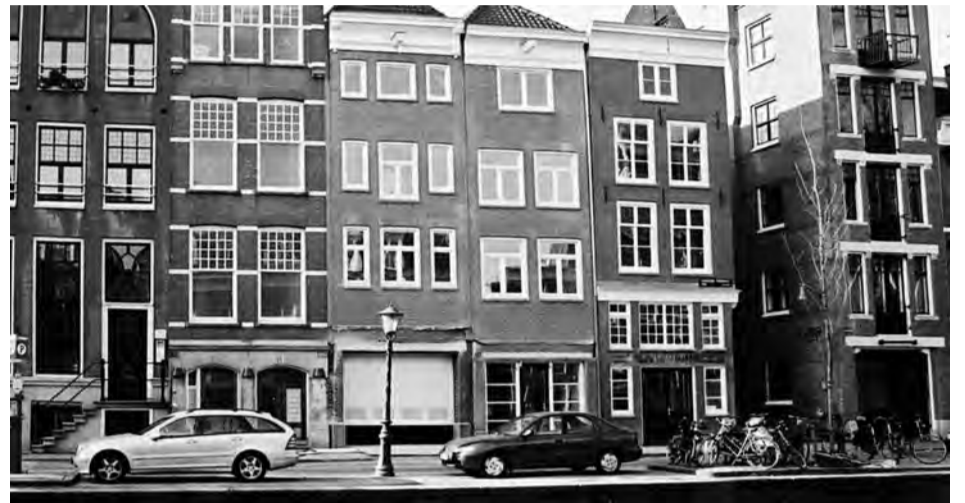
Stadhuisgarage zoals die was (boven) en is...
